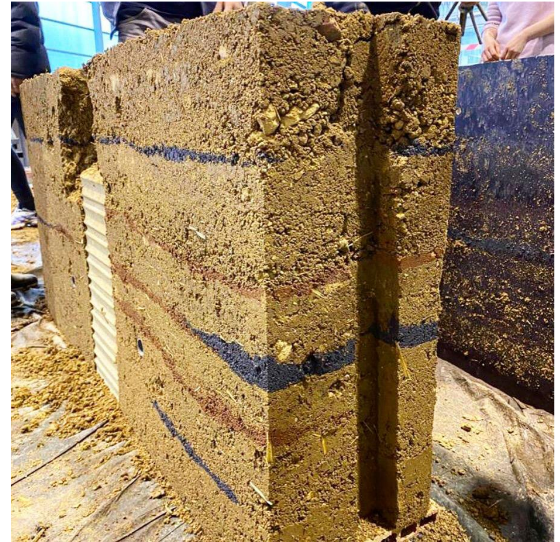
Portion d'un mur en pisé réalisé collectivement.
