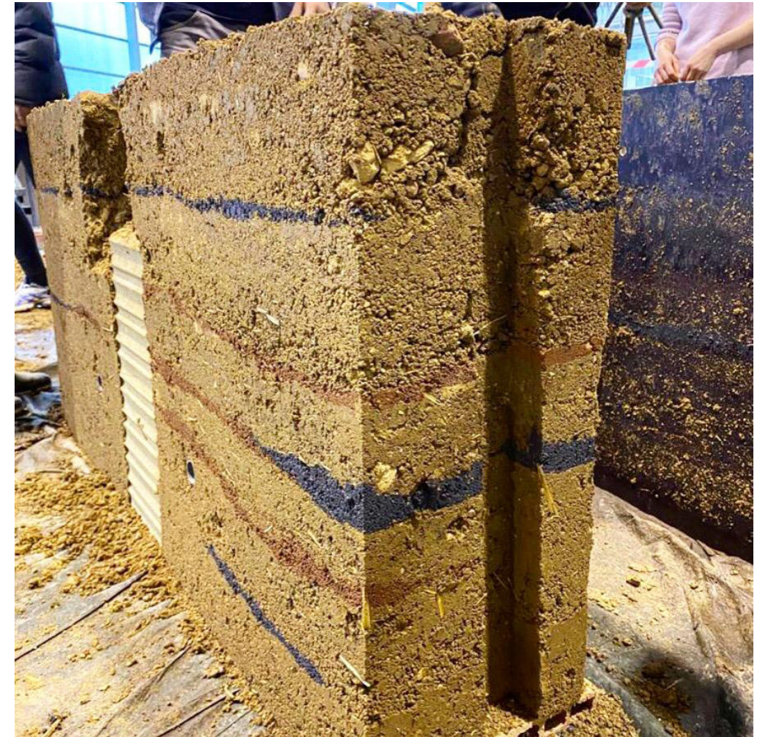
Portion d'un mur en pisé réalisé collectivement.
